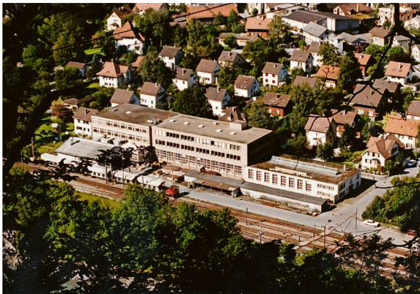
1982: Der vierte Ausbau am Erlenweg, bei dem der Mitteltrakt aufgestockt wurde.
