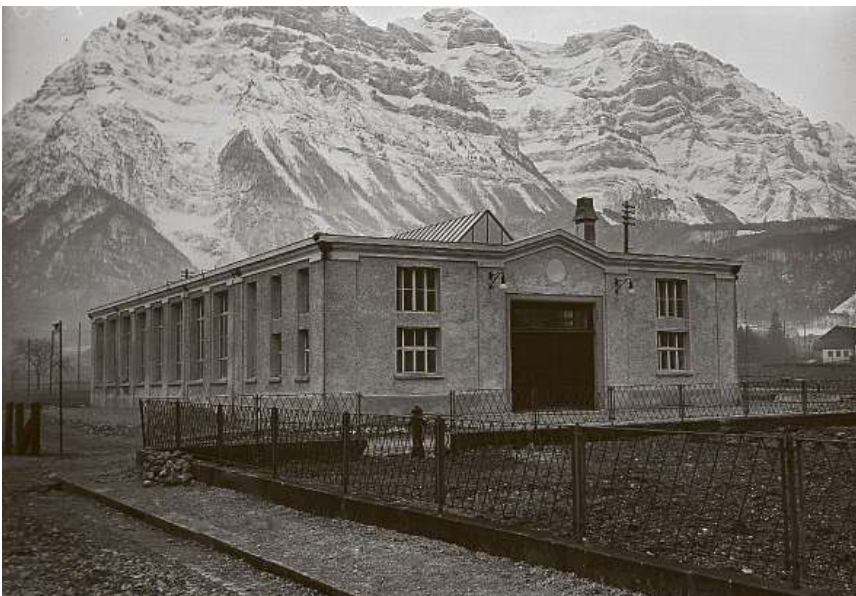
1923. Noch fehlt der Namenszug auf dem Dach des neuen Fabrikgebäudes.
